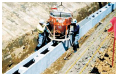
5.中詰めコンクリート打設
