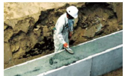
6.コンクリート均し作業
